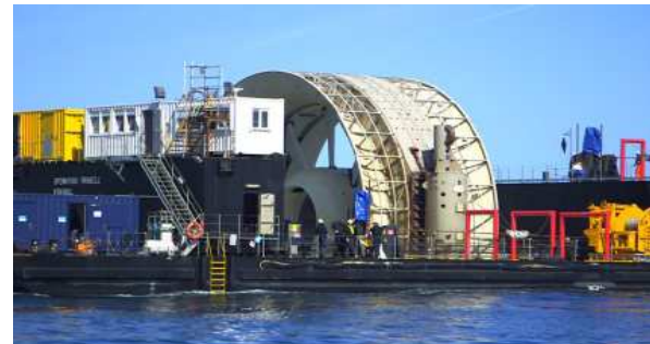
Hydrolienne Open Hydro sur la barge d'installation
